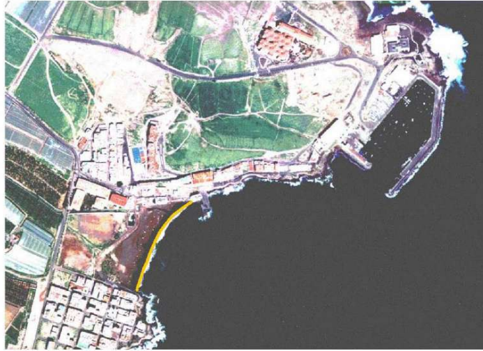
Figura 1. Estado actual de la línea de costa en la Playa de Melenara.
